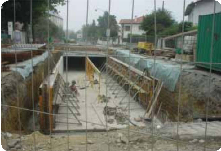
Construction du bassin Galas à Billère
