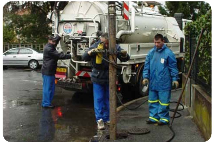
Hydrocurage et nettoyage d'une partie du réseau
